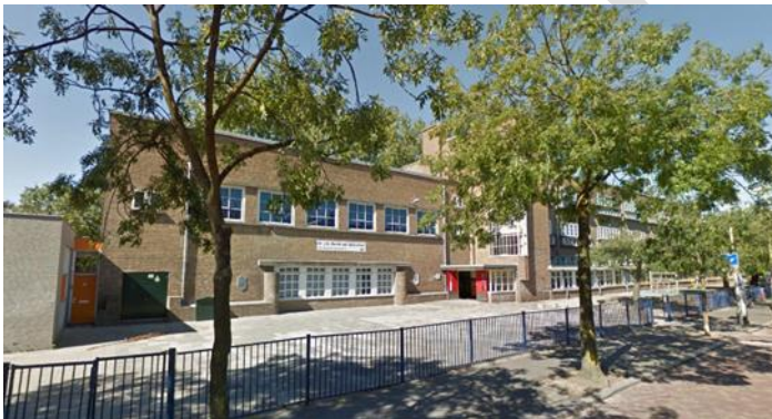
Foto: bestaande situatie
