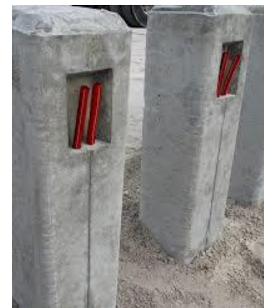
Bodemlussen in heipalen
